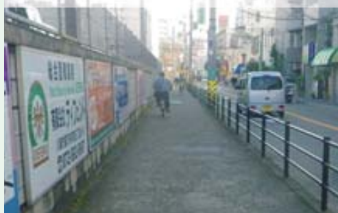
施工前 (コンクリート舗装)
