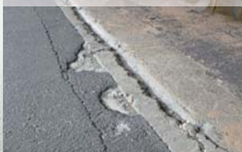
施工前 (コンクリート、アスファルト舗装)
